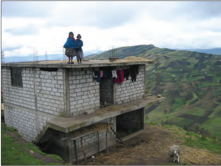
Fotografía 6.3: Una casa de concreto nueva. Nótese la falta de puertas y el tejado de la terraza sin terminar.
